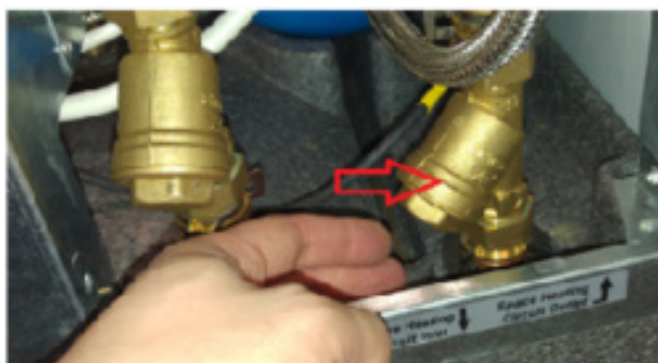
Fig. 96 : Strainer assembly
